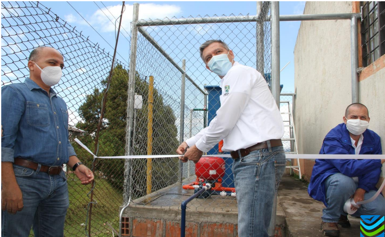
Foto /Vallecaucana de Aguas- Ptap- I.E. Central San Juan de Barragán Tuluá- Valle del Cauca
